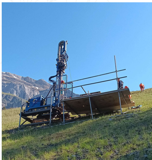
Sondeuse sur la digue
