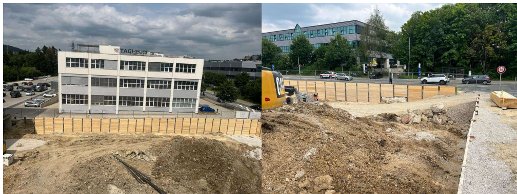
Réalisation de la berlinoise et pose de l'étaisage
