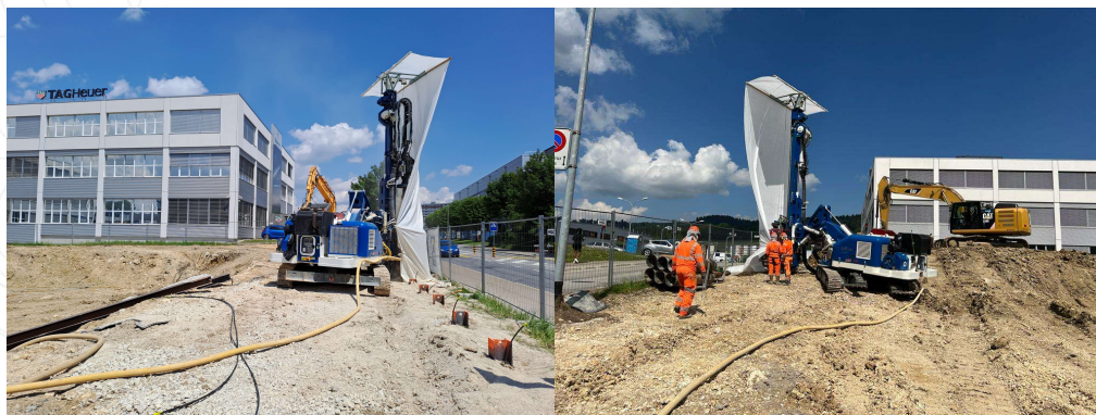
Réalisation de la berlinoise – Perforation des HEB 200
