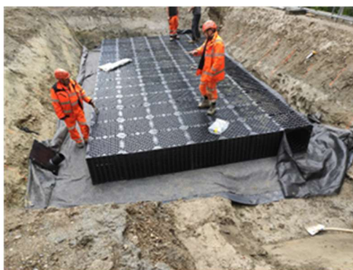
Pose du bassin de rétention
