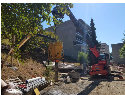
Bétonnage du mur
