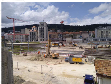
Réalisation des pieux et des piles
