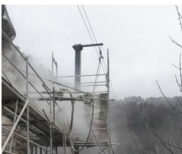
Réalisation des forages à la Ripamonti speedy-drill 180
