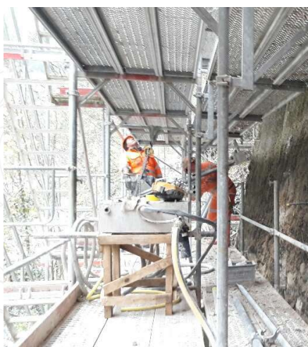
Réalisation des forages à la Ripamonti speedy-drill 180
