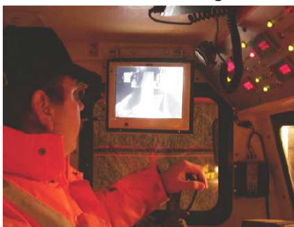
Contrôle du marinage
