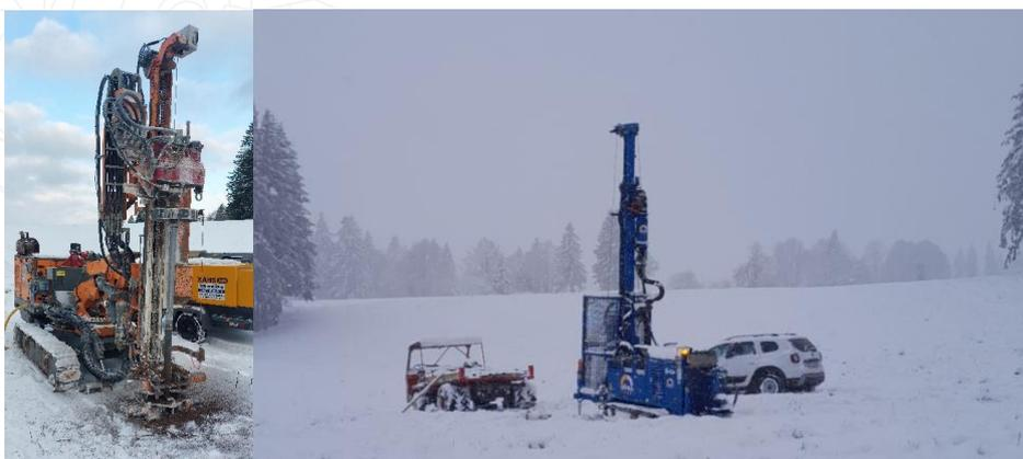
Photographies d'un sondage destructif avec la foreuse et de sondage carotté
