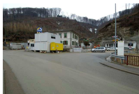
Accès à l'usine en fonction
