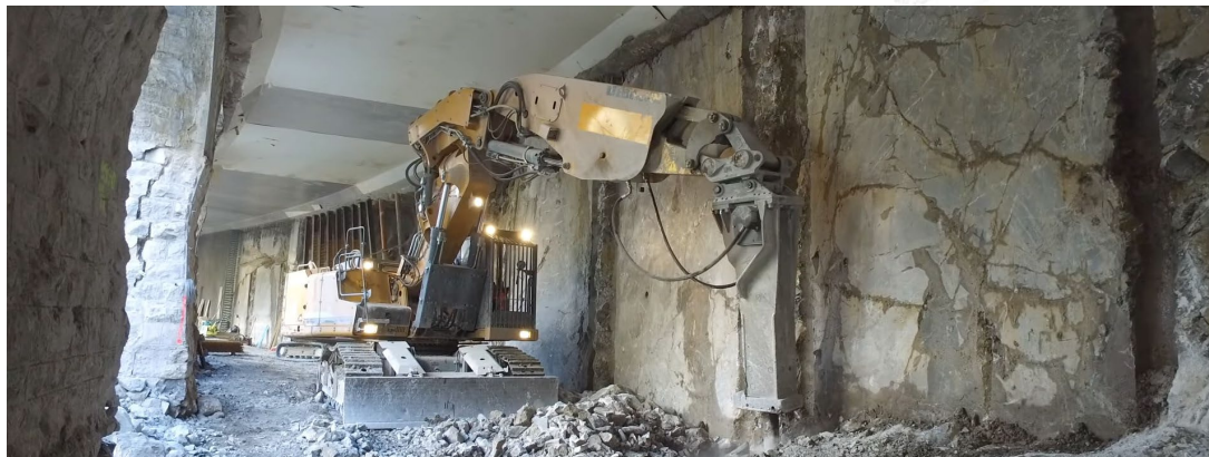
Démolition de la galerie de la Tine en taube sous la nouvelle dalle de couverture portée par les micropieux
