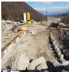
Les premiers travaux pour le tunnel ont consisté à réaliser des pieux verticaux en jetting. Il s'agit au total de 28 pieux Ø80 cm de 17,5 m de long et de 63 pieux Ø160 cm de 17,5 m de long.
