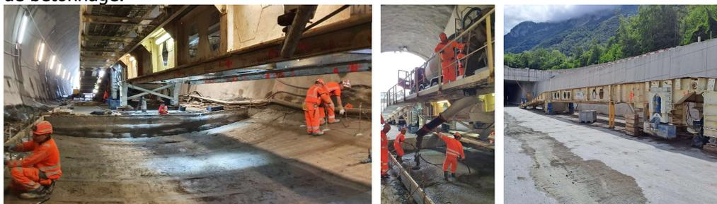
Pour les voûtes, nous réalisons des étapes de 9,0 m avec un coffrage de voûte sur mesure. La cure est assurée par deux chariots de 9,0 m. Chaque étape nécessite environ 100 m<sup>3</sup> de béton, car nous avons remplis préalablement les redents avec du béton projeté.
