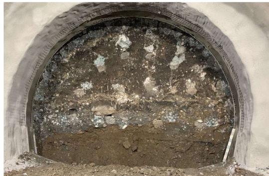
Il y a 45 colonnes (longueur 12 m) dans la voûte et 13 colonnes (longueur 15 m) dans le front de taille. Pour les réaliser, nous disposons d'une foreuse Soilmec ST60 et d'une pompe haute pression Soilmec 7T600J, ainsi que d'une installation de production de ciment. Avec notre équipement, nous travaillons avec une pression d'injection de 450 bars. Le spoil est évacué à l'aide d'une pompe péristaltique et de camions.
