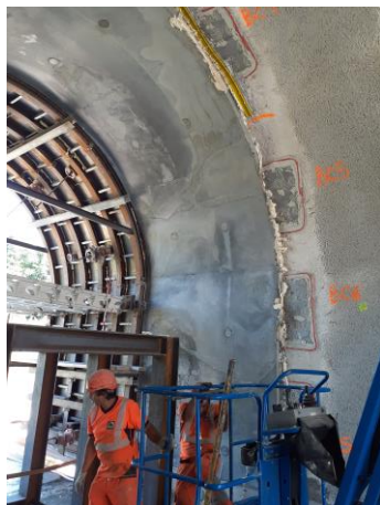
Béton coulé et joints
