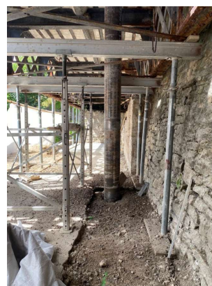
Tubage entre niveau
