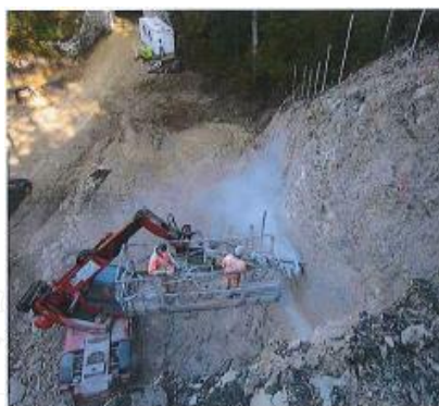
Sécurisation du front du portail du tunnel des Rutelins
