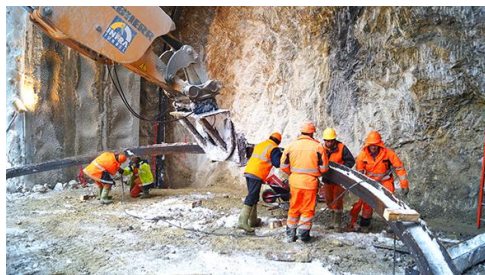
Mise en place d'un cintre métallique
