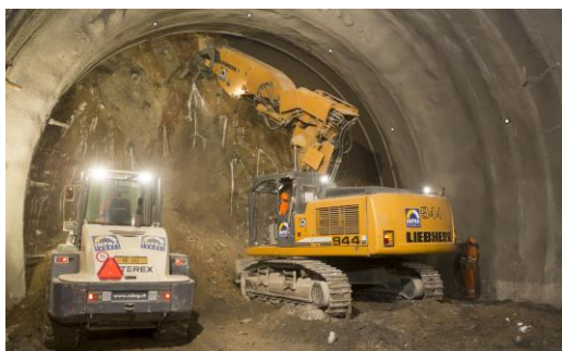
Excavation du Tunnel
