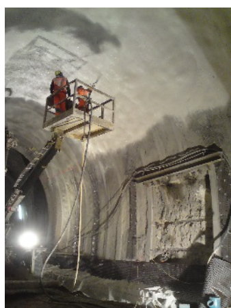
Béton projeté renforcé de fibre PP Etanchéité projetée Masterseal®
