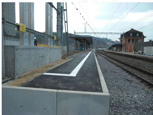
Quais en gare d'Eclépens
