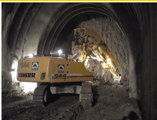
Pelle 944 Tunnel excavant la pleine section
