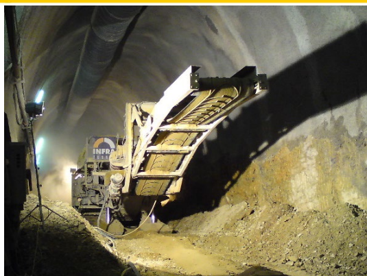
Haveuse ET-410 excavant le stross du tunnel Sud
