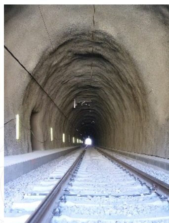
Béton projeté renforcé de fibre PP Etanchéité projetée Masterseal®
