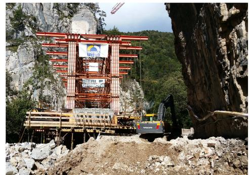
Le coulage du tablier s'est effectué suspendu à un cintre de maintien.
